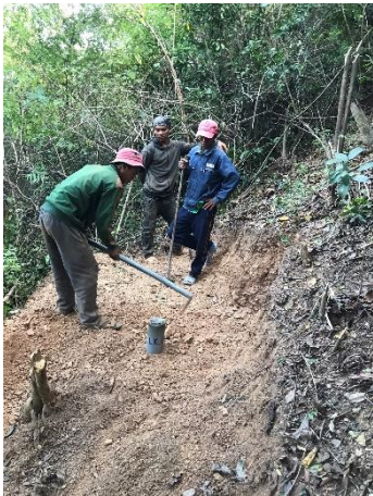
Hiện trạng lớp phủ tại khu vực lỗ khoan LK1
