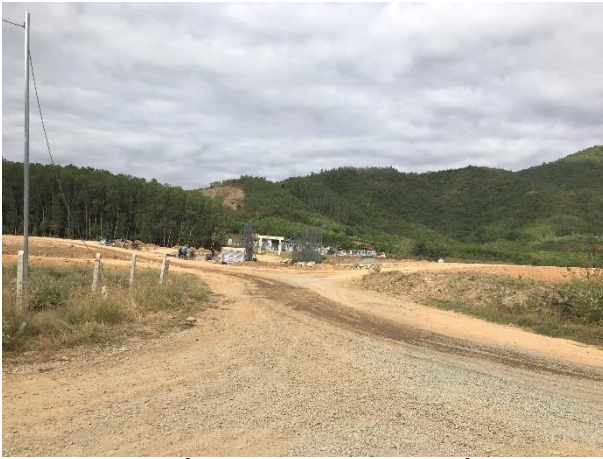
Khu vực đầu đường vào khu đất dự án
