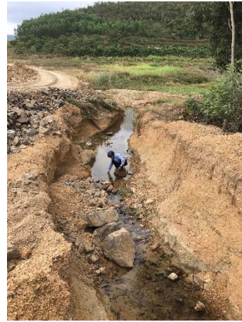
Rãnh thoát nước phía Đông
